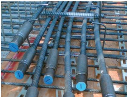
**Ancon-MBT Betonstahlkupplungen** sind einfach, sicher und schnell einzubauen, auch dort, wo Platz ein Problem oder ein Drehen der Bewehrung unmöglich ist. Wichtigste Vorteile: Kein Gewindeschneiden, keine Schweißung, visuelle Kontrolle auf der Baustelle durch Bauleitung möglich. MBT ist ÜA-Zertifiziert und hat zahlreiche internationale Zulassungen (USA, Deutschland, etc.).
