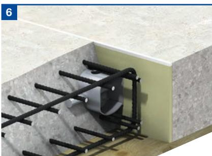
Nun kann die Bewehrung um den Dorn gelegt werden, wobei wiederum auf die Bewehrungsdimensionen und die erforderliche Betonüberdeckung geachtet werden muss. Der Einbau wird durch das Einbringen des Betons abgeschlossen.
